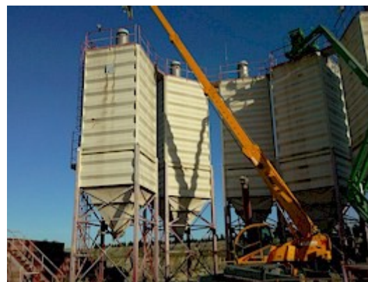
Cimenterie, sablière Véolia
